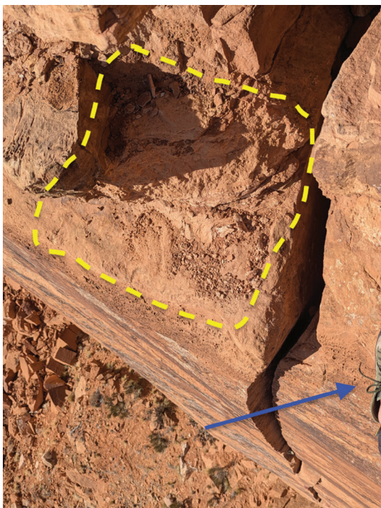
埃斯卡兰特峡谷的攀岩线路相比其他区域不算热门，岩壁上仍存在松动的岩石。照片中黄色虚线标注的区域，就是此前被一名攀登者碰落的巨大岩石原本所在的位置。照片边缘处(蓝色箭头指向)有一只攀登者的脚，可用于直观对比这块落石的庞大体量。图片来源: Chase Smith
