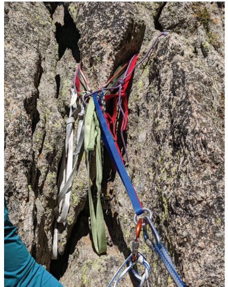
这个位于怀俄明州风河山脉（Wind River Range）的锚点存在许多绳降保护站常见的问题：受紫外线照射老化、铝制绳降环卷边变形，以及被岩块卡住或隐藏在视线之外的扁带。
